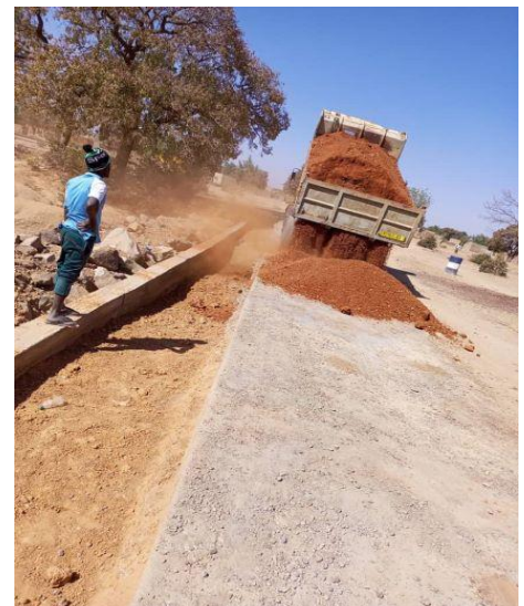
Travaux sur le barrage
